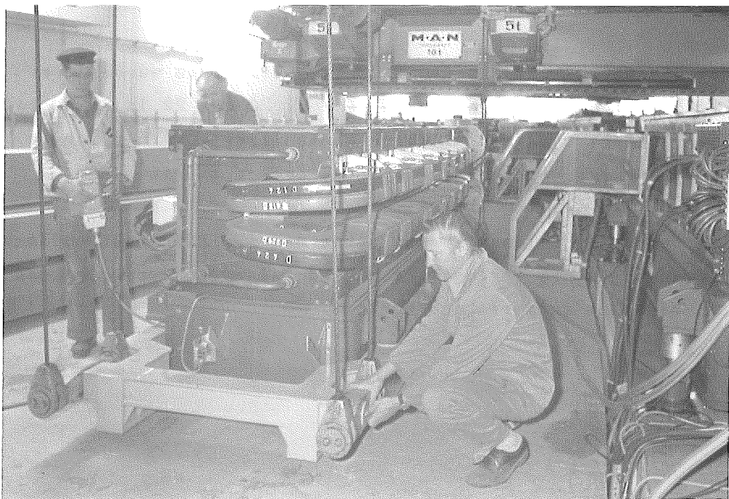
Abb. 2: Befestigung der Sektor-Traverse an den Seilzug des Ring- (26182/2) kran
