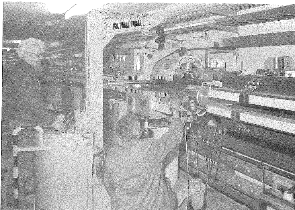
Abb. 12: Aufsetzen der oberen Hälfte von Quadrupol und Sextupol (26231/27) mit dem "Schimobil"
