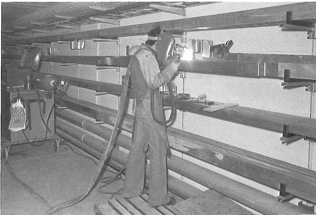
Abb. 10: Verschweißen der Dehnungsbänder mit den Stromschienen (25951/20)
