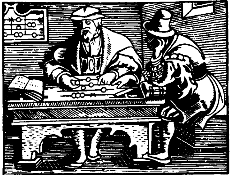
Das Rechenhilfsmittel bis zum hohen Mittelalter: Rechenbrett zum Rechnen auf den Linien. Der Kaufmann legt Rechnung auf seiner Bank mit Rechenpfennigen; der Betrag von 3161 wird gerade zum Kummer des Kunden um 10 erhöht.
