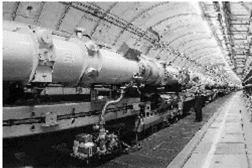
Abbildung 5: Blick in den HERA-Tunnel
