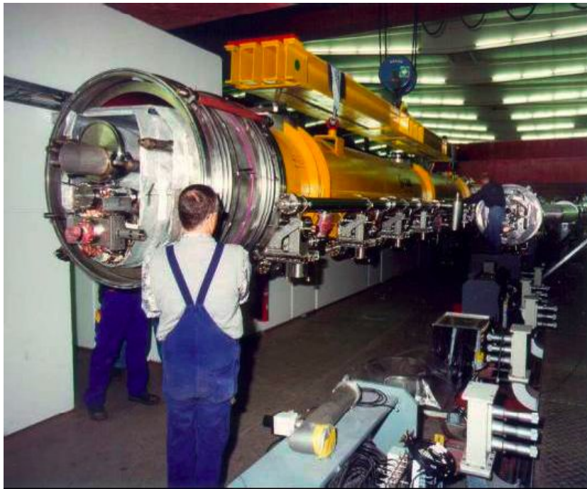
Abbildung 1.8: Montage eines Kryomoduls in der TESLA Test Facility am DESY. [15]
