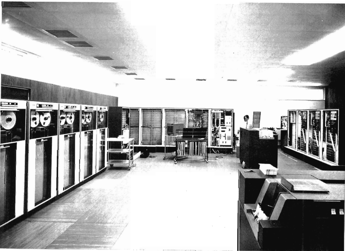
Bild 8: Blick in das Rechenzentrum bei DESY
