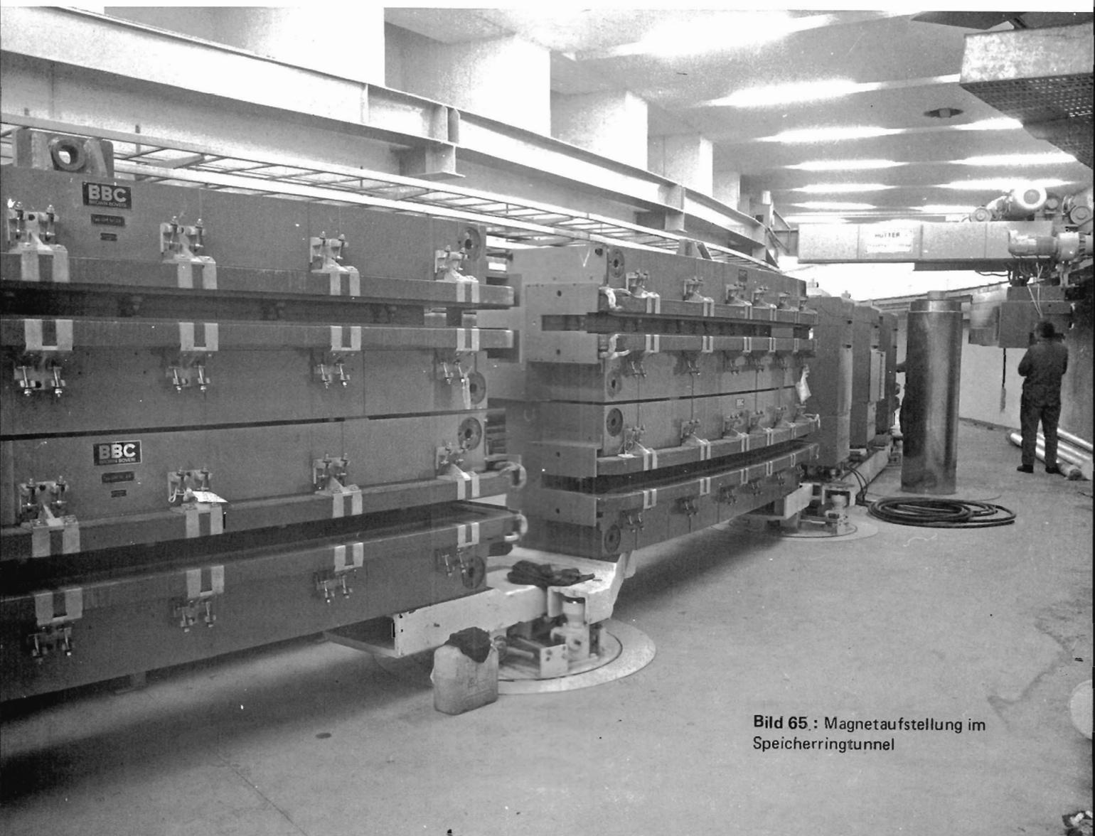
**Bild 65:** Magnetaufstellung im Speicherringtunnel
