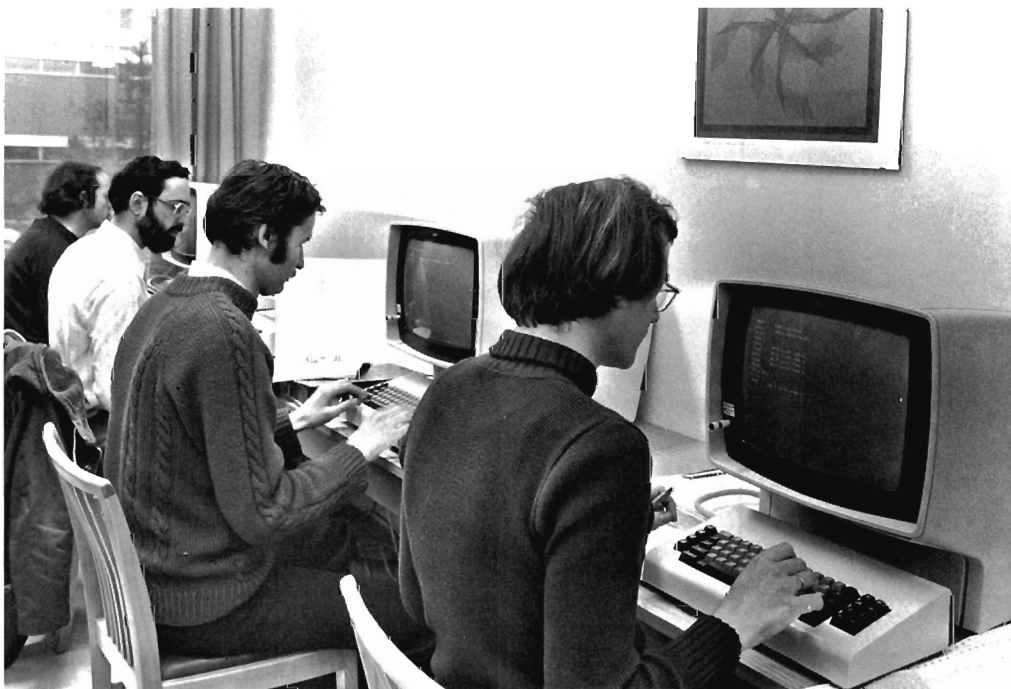
Abb. 106 TSO-Terminals im Benutzer-Raum
