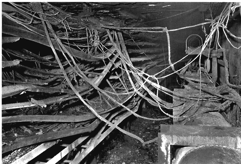
Abb. 103 Blick in den Kabelkanal
