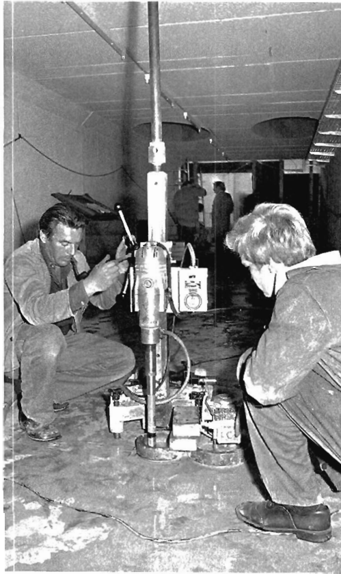
Abb. 98 Bohren der Löcher für die Magnetgestelle (25372/25)
