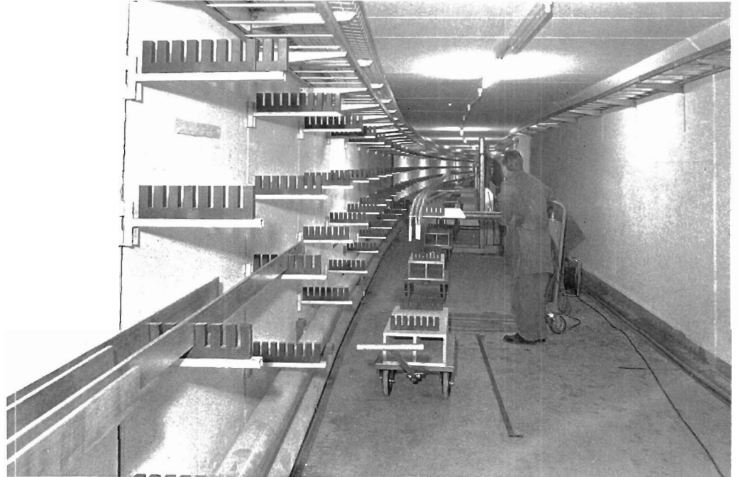
Abb. 95 Stromschienenmontage
