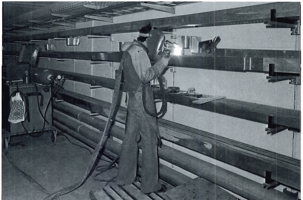
Abb. 87 Verschweißen der Dehnungsbänder mit den Stromschienen im PETRA -Ringtunnel.
