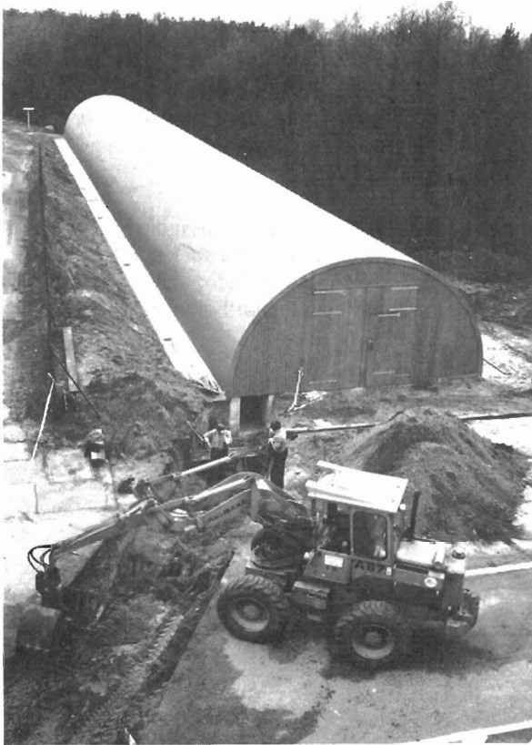
Abb. 23.5: Die 70 m lange Testhalle für den Verbundtest von 12 supraleitenden Magneten.
