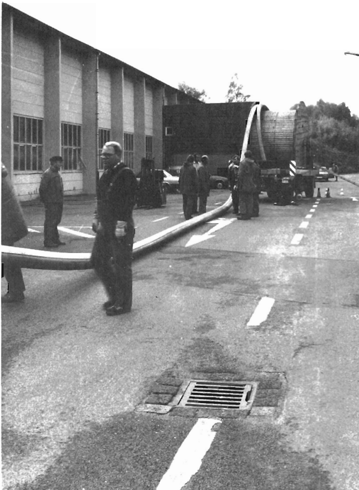
Abb. 22.4: Verlegen einer flexiblen 4fach-Transferleitung für flüssiges und gasförmiges Helium.
