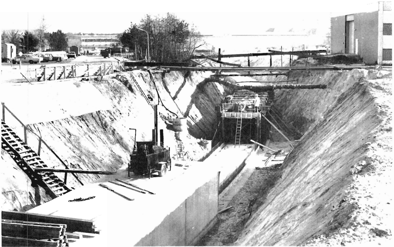
Das Bild zeigt den letzten Bauabschnitt des 2.3 km langen Ringtunnels für die Positron-Elektron-Tandem-Ring-Anlage PETRA. Der Tunnel verläuft zum Teil oberirdisch, zum Teil unterirdisch.
