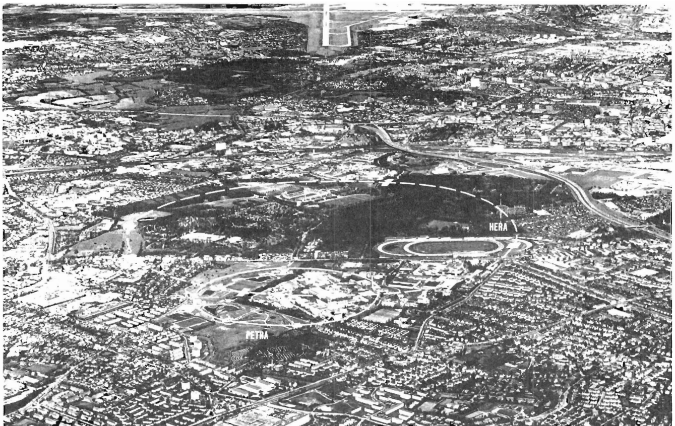
Abb. 20.1: Die Lage des HERA-Tunnels in Hamburg-Bahrenfeld. Rechts innerhalb des HERA-Ringes liegt die Süd-Halle neben der Trabrennbahn. (Freigabe-Nr. 262/81 Luftamt Hamburg)
