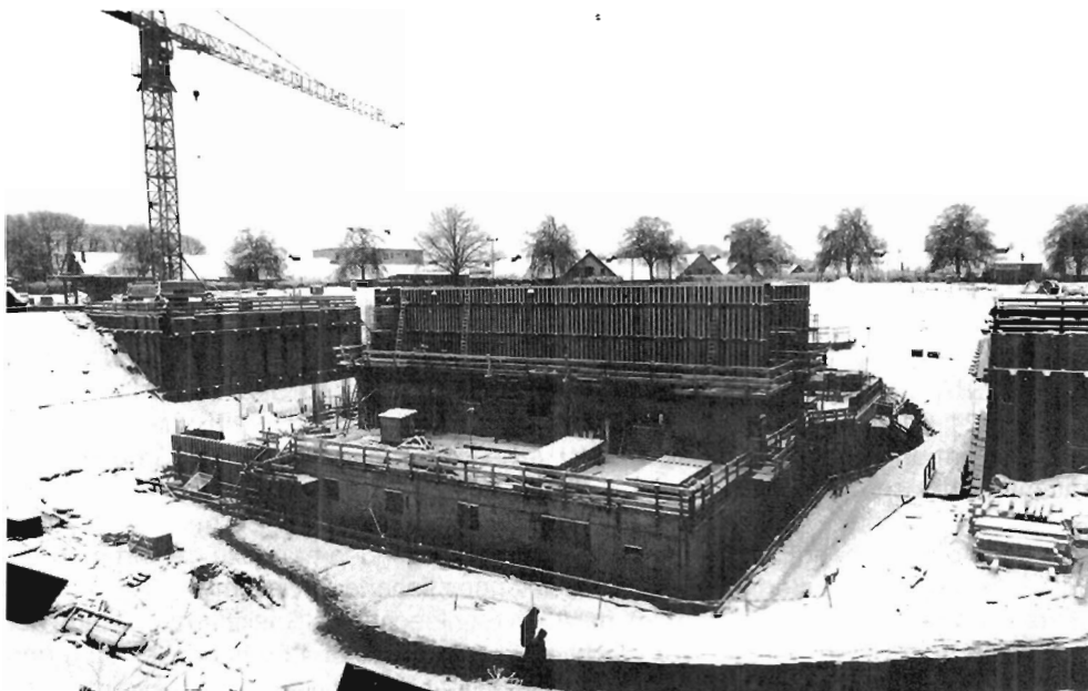
Abb. 20.9: Sechs Wochen nach der Genehmigung wurde mit den Baumaßnahmen zu HERA angefangen. Das Bild unten zeigt die Baustelle Süd im Winter 1984.
