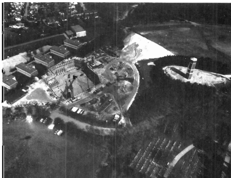
Abbildung 88: Die HERA-Halle Nord im April des Berichtsjahres. (38635, Freigabe-Nr. 264/85 LA-HH)
