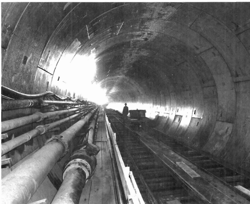
Abbildung 92: Blick in den ersten im Rohbau fertiggestellten Tunnelabschnitt. (38932/27)
