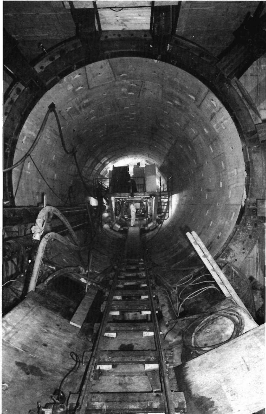
Abbildung 81: Die ersten 30 m des HERA-Tunnels sind gebaut. Im Hintergrund erkennt man den Nachläufer der Schildvortriebsmaschine "HERAKLES". (38660/25)
