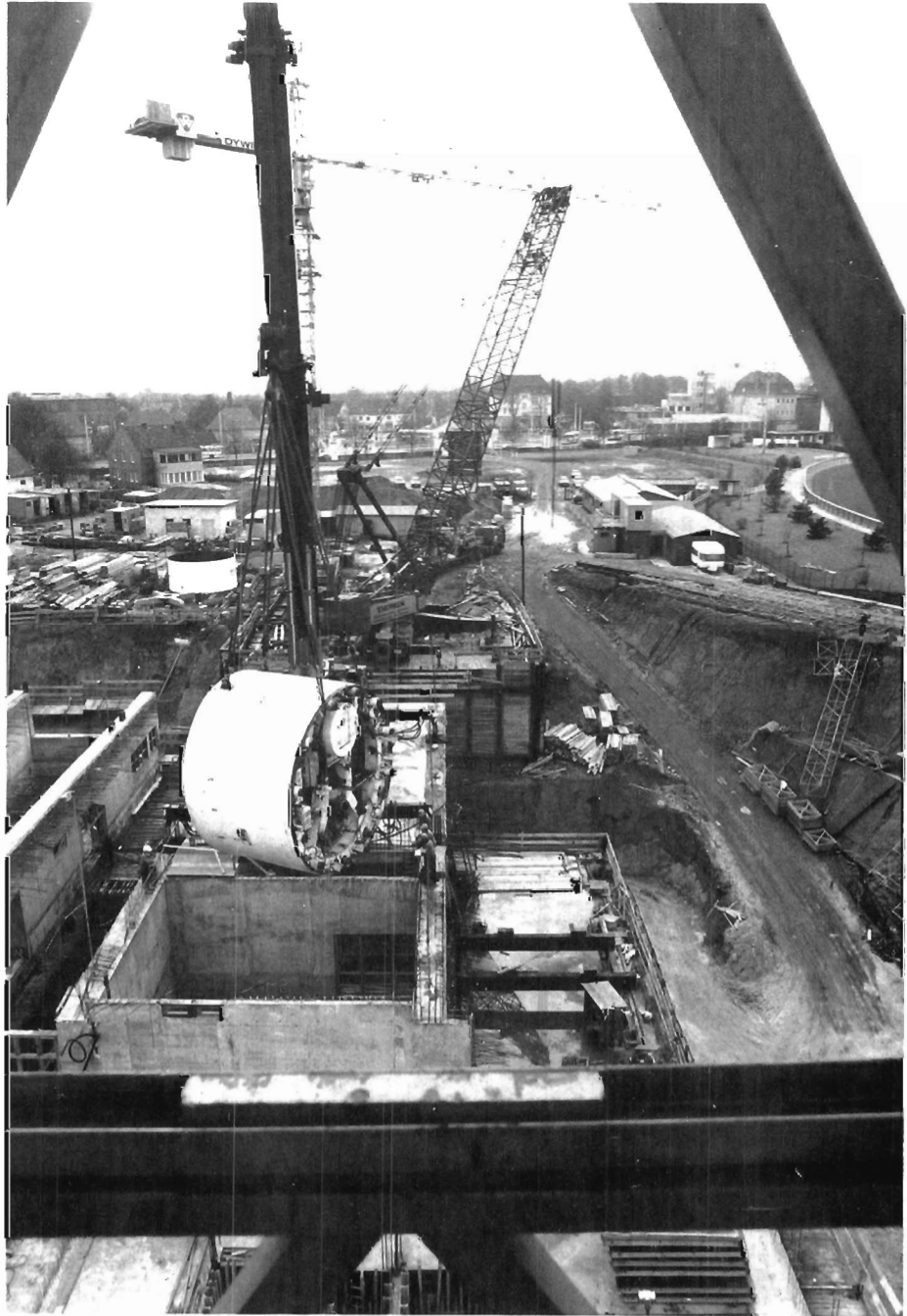
Abbildung 89: Die schwere Schildvortriebsmaschine wird in die Halle Süd hinabgelassen. (38446/14)
