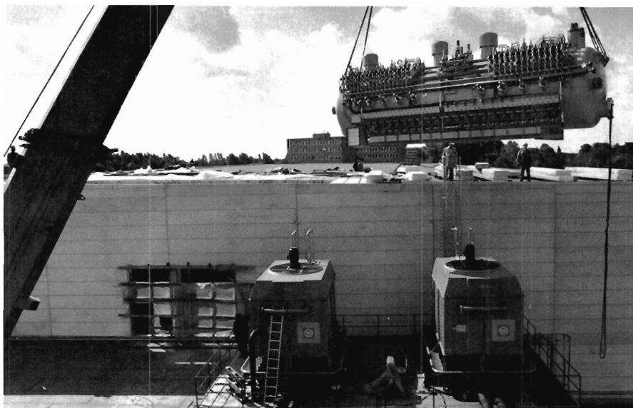
Abbildung 82: Die Verteilerbox der Kälteanlage wird in die Halle gehoben. (39738/32)
