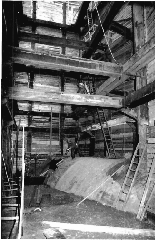
Abbildung 87: Anschluß des Protonen-Transferkanals zwischen PETRA und HERA an den HERA-Tunnel; rechts der freigelegte Tunnel. (40246/7)
