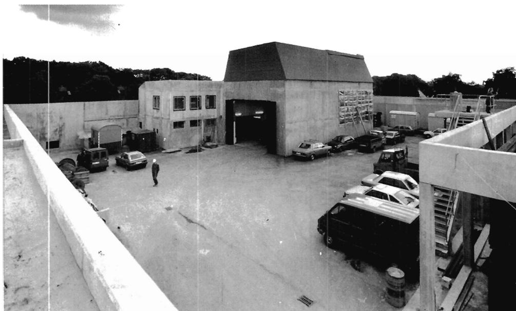
Abbildung 71: Die HERA-Halle Süd kurz nach ihrer Fertigstellung mit provisorischem Dach und den Stützmauern für den Sichtschutz-Erdwall. (40669/7)
