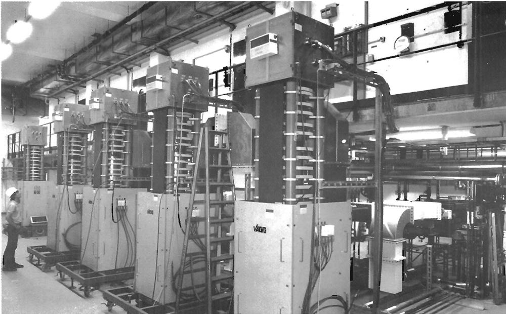
Abbildung 69: Die ersten Hochfrequenzsender für den Elektronenring von HERA. (40692/18)
