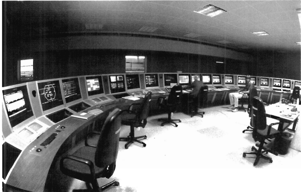
Das Foto zeigt den HERA-e-Ring Kontrollraum vor der ersten Inbetriebnahme der Maschine.
