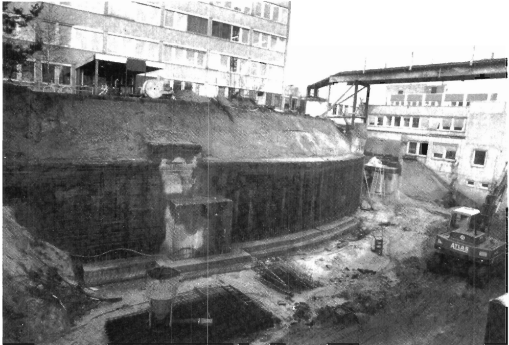
Abbildung 69: Bauarbeiten am DORIS-Beschleuniger. (42135/34)
