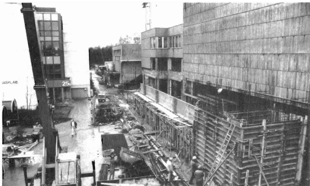
Abbildung 55: Bauarbeiten am Gebäude HASYLAB IV. Links ist das HASYLAB-Bürogebäude zu sehen. Im Hintergrund rechts das Gebäude des Europäischen Molekularbiologie-Laboratoriums EMBL. (Foto: W. Drube)
