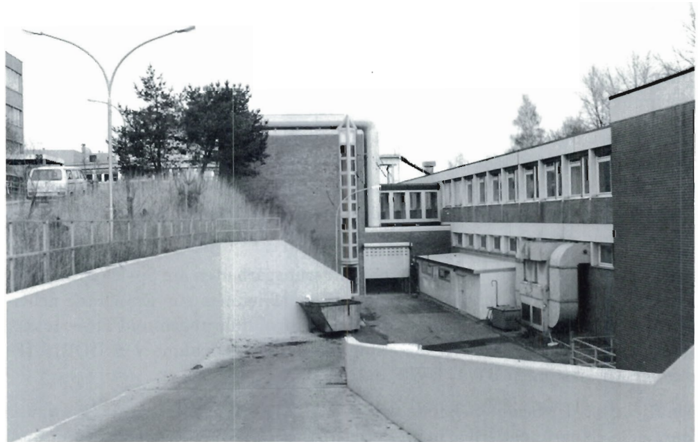
Abbildung 40: Blick über die Zufahrt auf die HASYLAB V-(hinten) und LINAC II-Gebäude (rechts).
