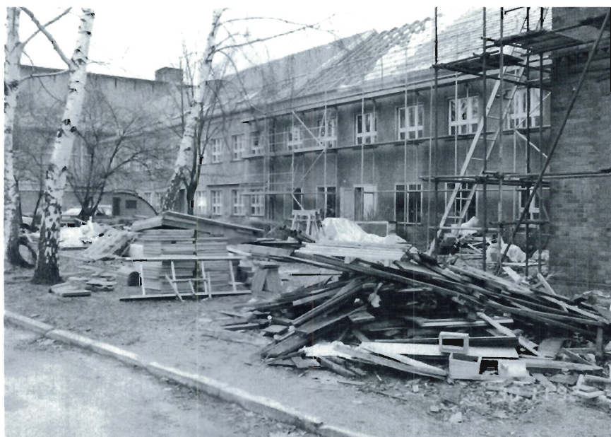
Abbildung 77: Sanierungsarbeiten am Laborgebäude.
