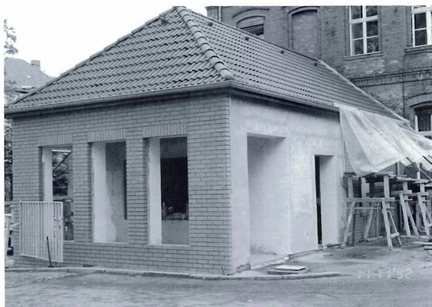
Abbildung 78: Umbau des Eingangsbereiches des Zeuthener Instituts.
