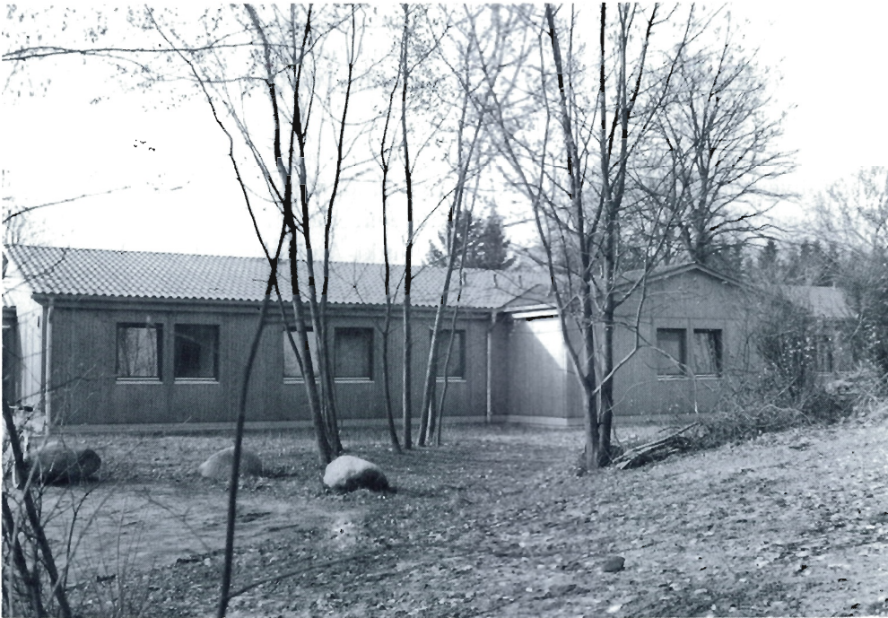
Abbildung 112: Das neu errichtete Gästehaus. (42496/4)
