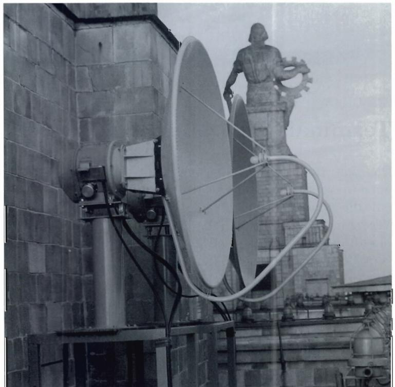
Abbildung 100: Richtfunkanlage für die Verbindung zwischen der Moskauer Staatuniversität und den anderen Moskauer Instituten.
