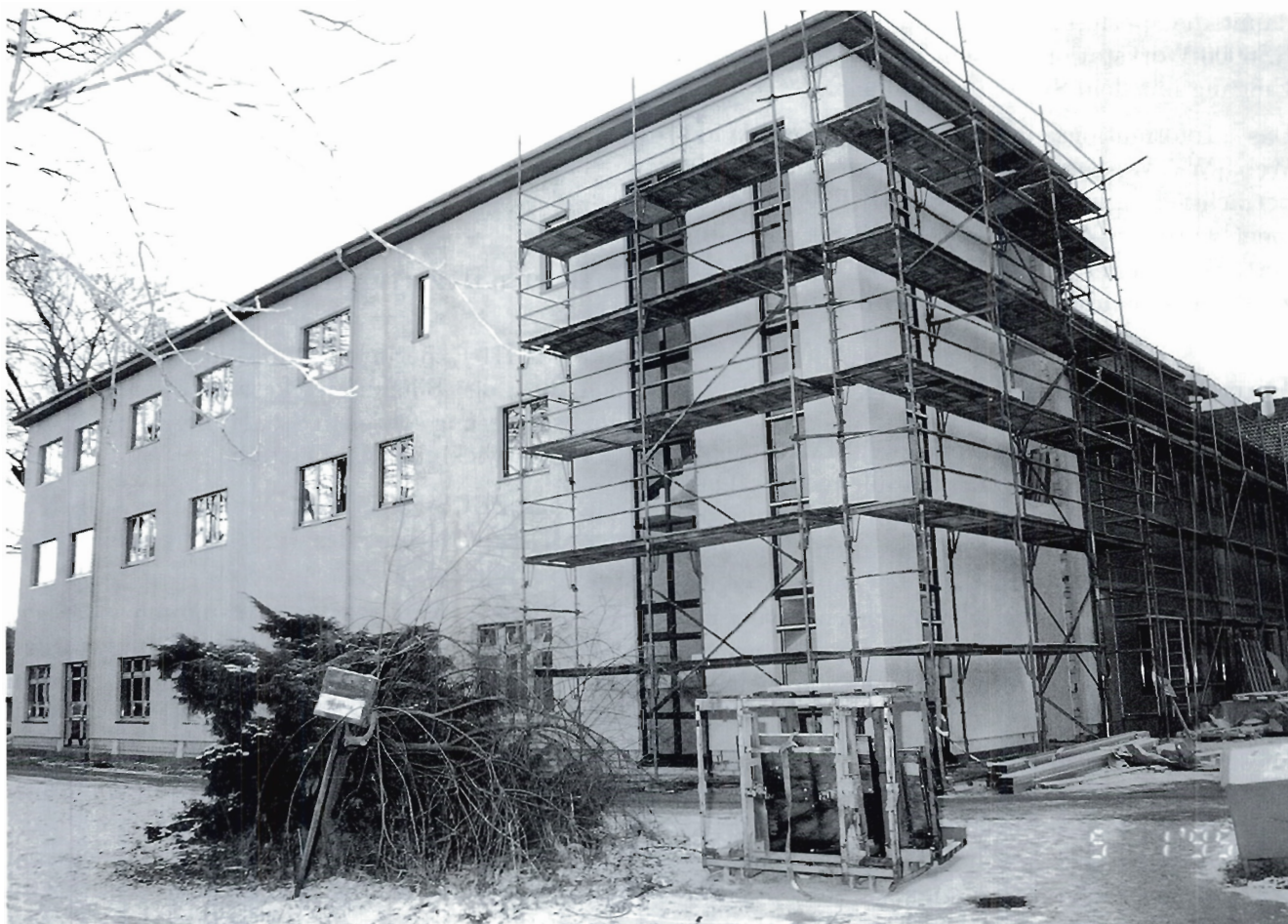
Abbildung 81: Umbauung der ehemaligen Beschleunigerhalle.
