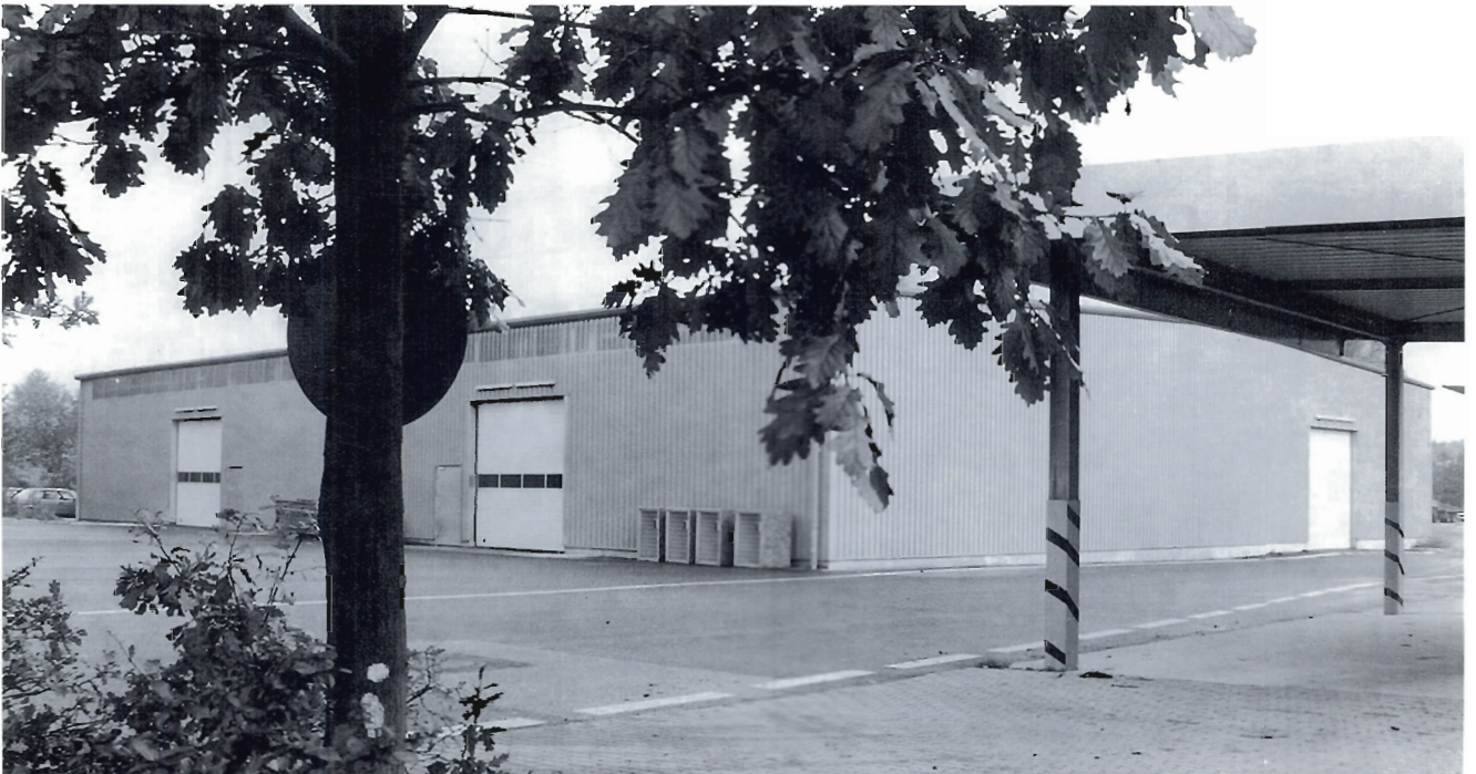
Abbildung 122: Die neue Kabelhalle mit einer Nutzfläche von 1400 qm. (12605/14)
