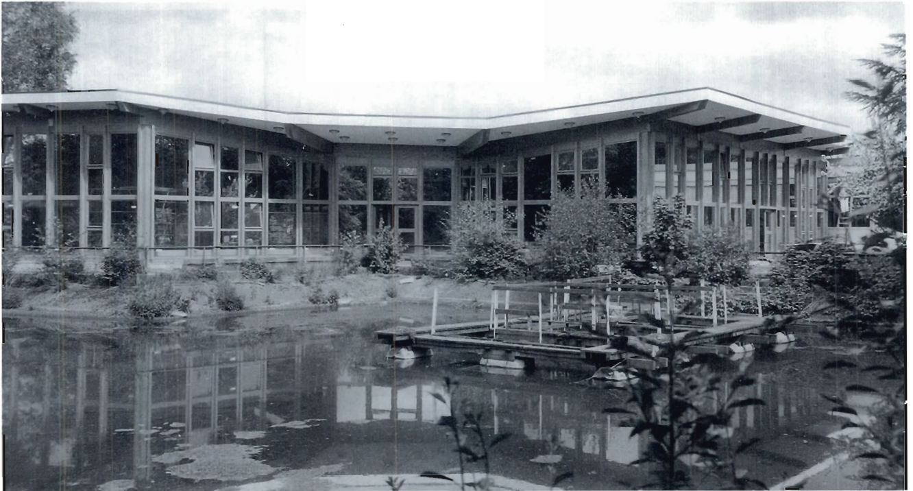
Abbildung 114: Außenansicht der Kantinenerweiterung. (42665/23)
