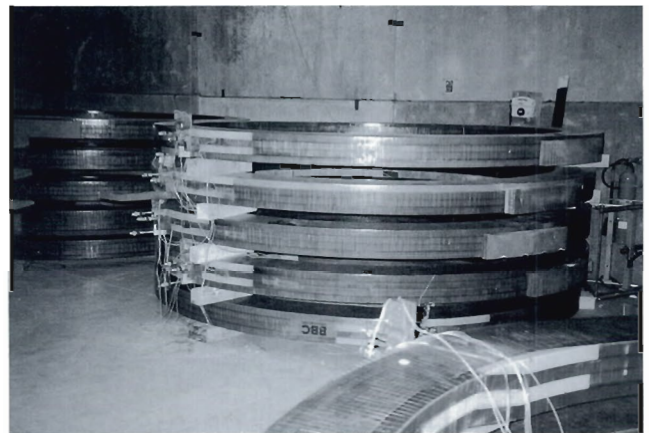
Abbildung 121: Die Spulen aus dem ehemaligen ARGUS-Detektor liegen zum Einbau in den HERA-B Magneten bereit. (Foto: K. Sinram)
