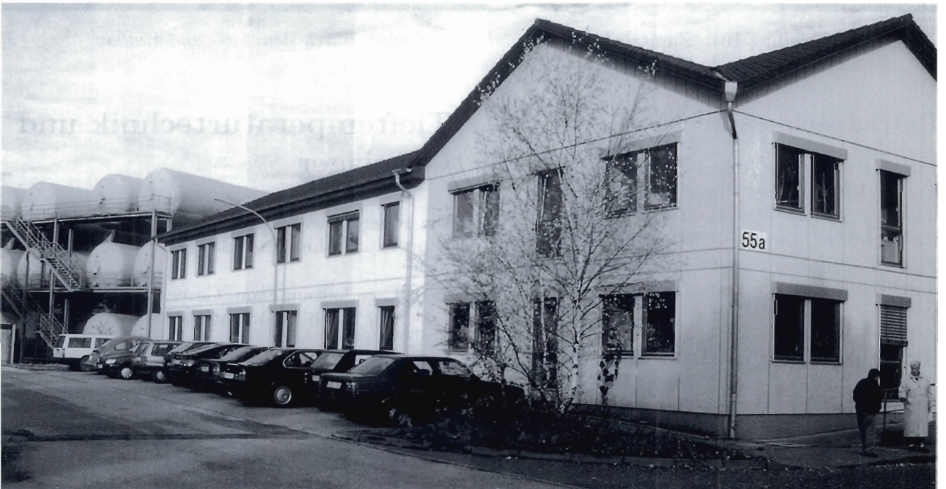
Abbildung 103: Das Gebäude 55a mit Erweiterung. (42812/11)
