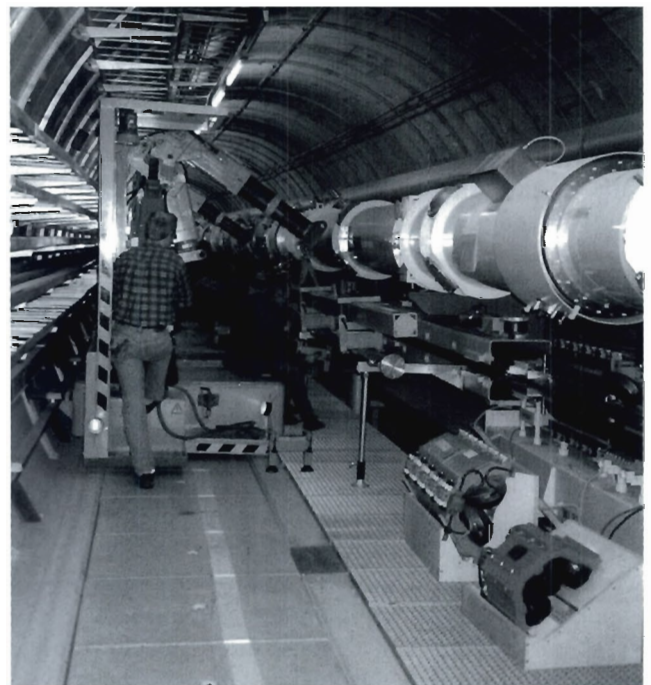
Abbildung 131: Anlieferung einer Vakuumkammer am Einbauort mit der HERA-TRAM.
