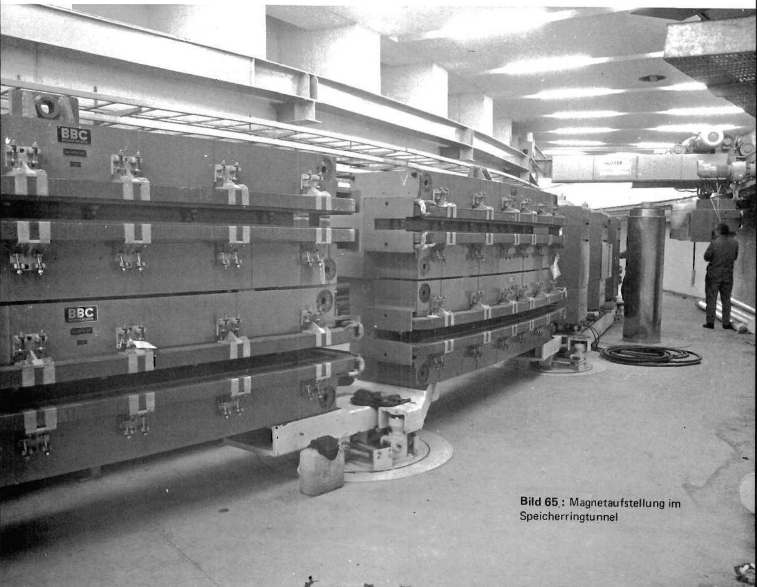
**Bild 65:** Magnetaufstellung im Speicherringtunnel
