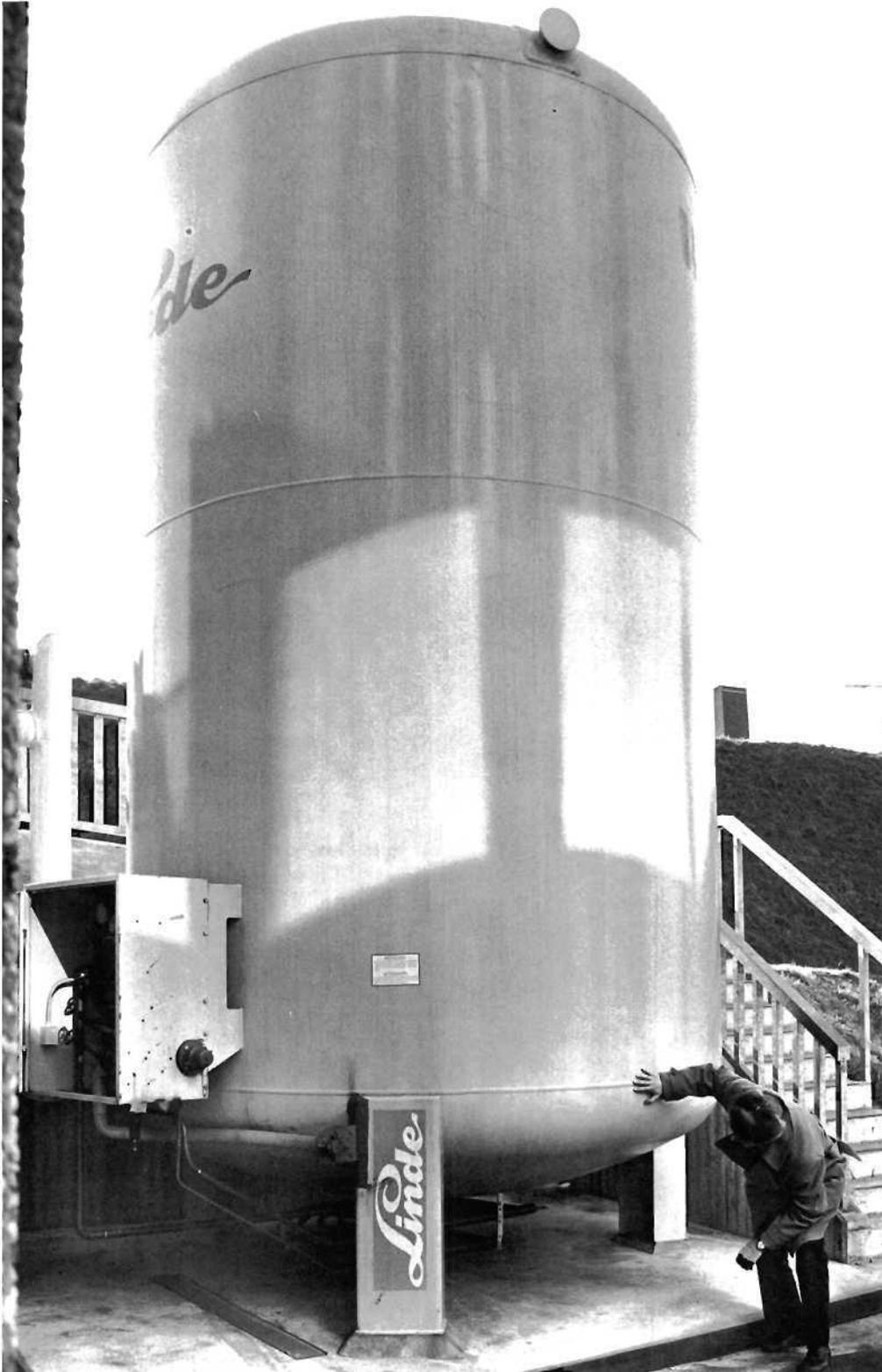
Abb. 109 FI. Stickstoff-Versorgungstank – Pluto und Speicherring
