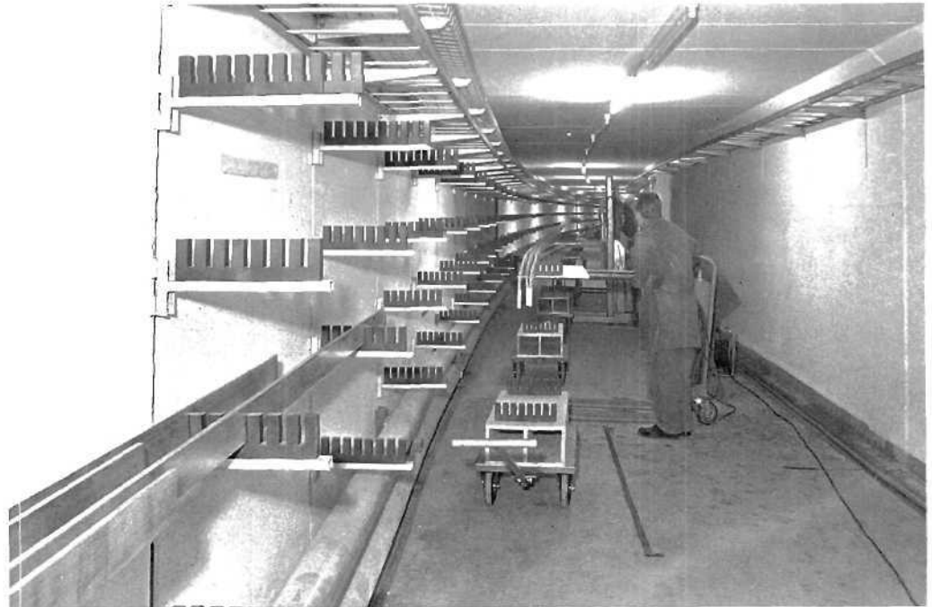
Abb. 95 Stromschienenmontage
