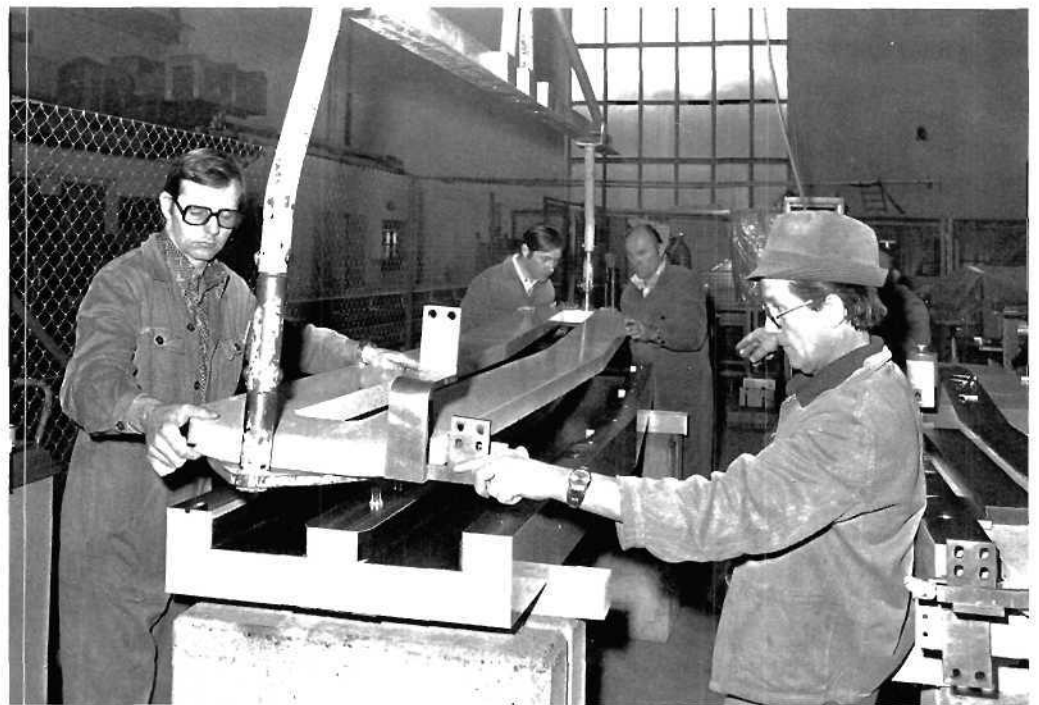
Abb. 87/88 Montage der Injektionsdipole
