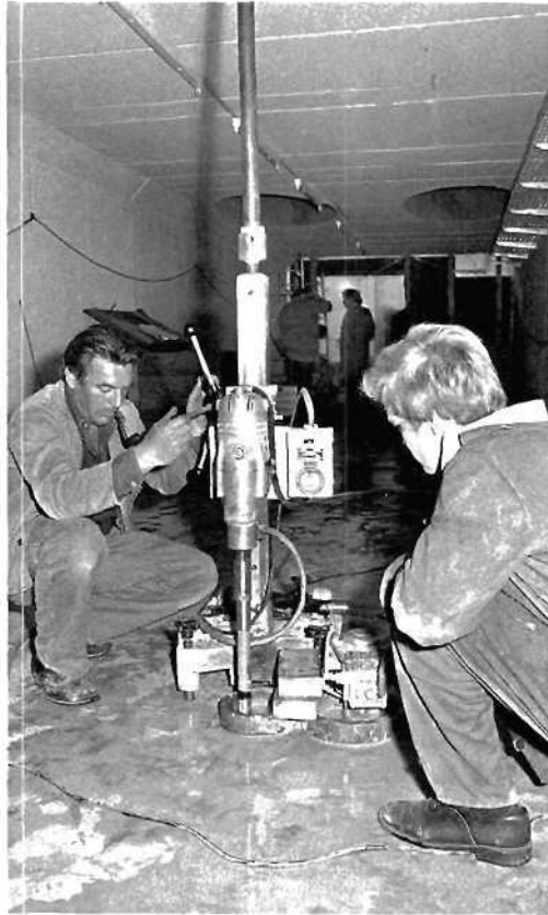
Abb. 98 Bohren der Löcher für die Magnetgestelle (25372/25)
