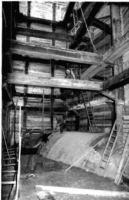
Abbildung 87: Anschluß des Protonen-Transferkanals zwischen PETRA und HERA an den HERA-Tunnel; rechts der freigelegte Tunnel. (40246/7)
