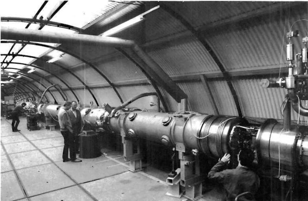
Abbildung 66: Systemtest von supraleitenden Magneten unter realistischen HERA-Bedingungen und bei Temperaturen um 4 Kelvin. (40467/19)
