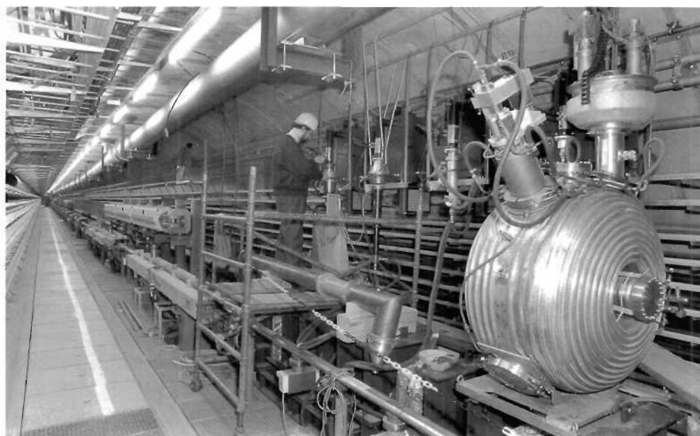
Abbildung 63: Aufbau eines kompletten 208-MHz-Hochfrequenzsystems für die Beschleunigung von Protonen im HERA-Tunnel.
