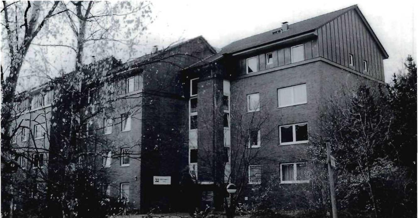
Abbildung 102: Gästehäuser 2 und 3 mit der neuen Geschoßaufstockung. (42812/23)
