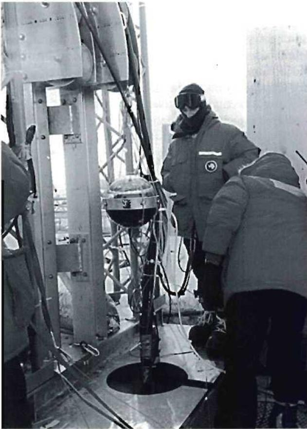
Abbildung 95: Montage eines optischen Moduls für das AMANDA-Experiment.
