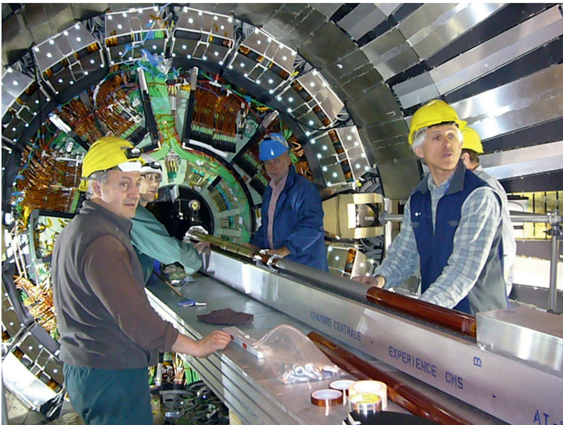
Abbildung 59: Einbau des zentralen Strahlrohres.
