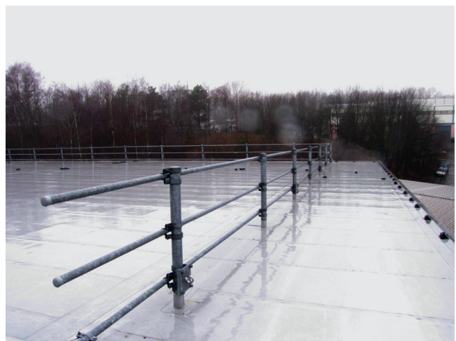
Abbildung 196: Dach von Gebäude 80.
