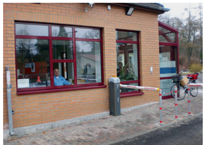
Abbildung 185: Neu gestalteter Eingangsbereich in Zeuthen.
