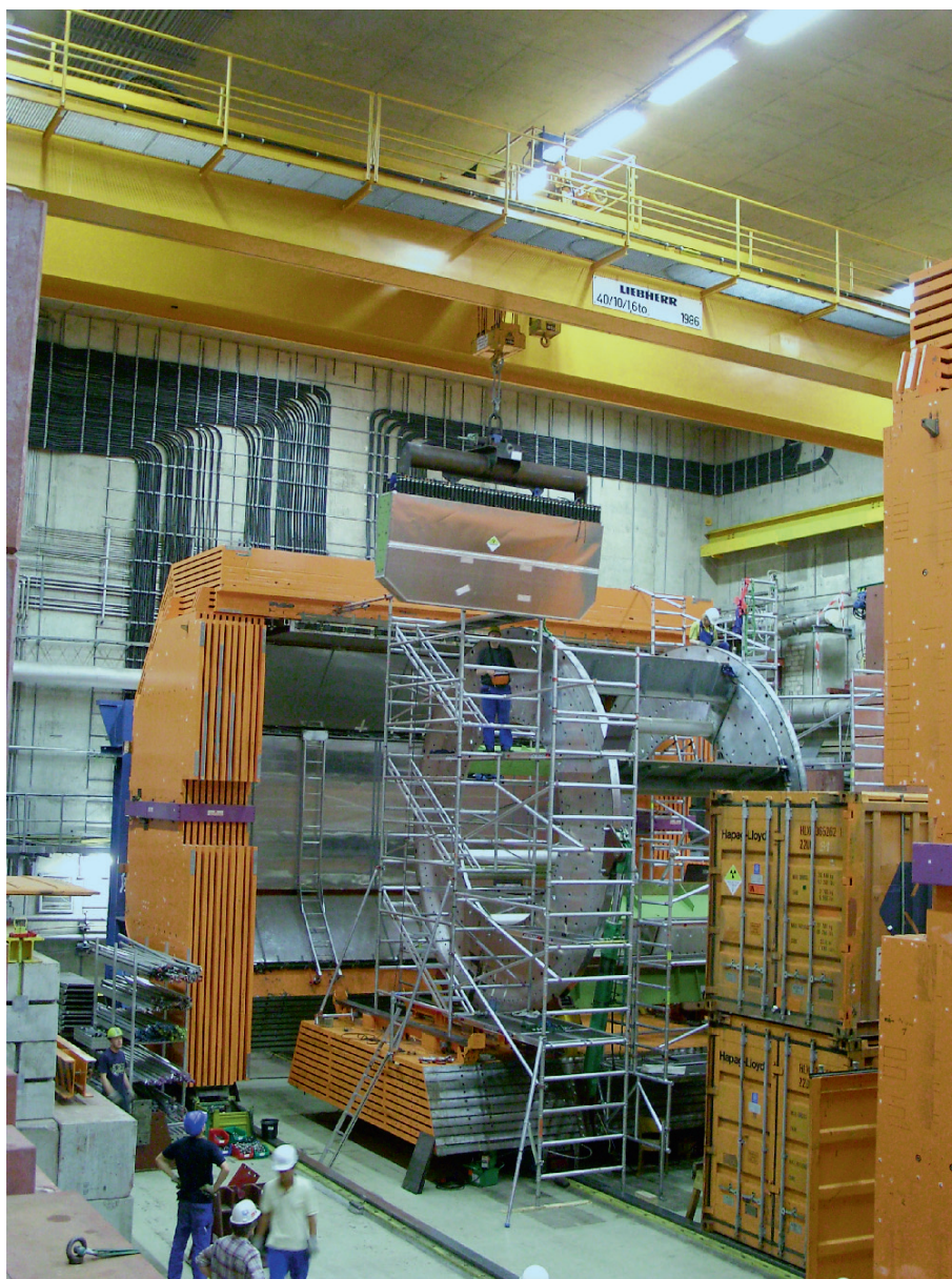
Abbildung 31: Ausbau des letzten Urankalorimetermoduls aus dem ZEUS-Detektor im September 2008.
