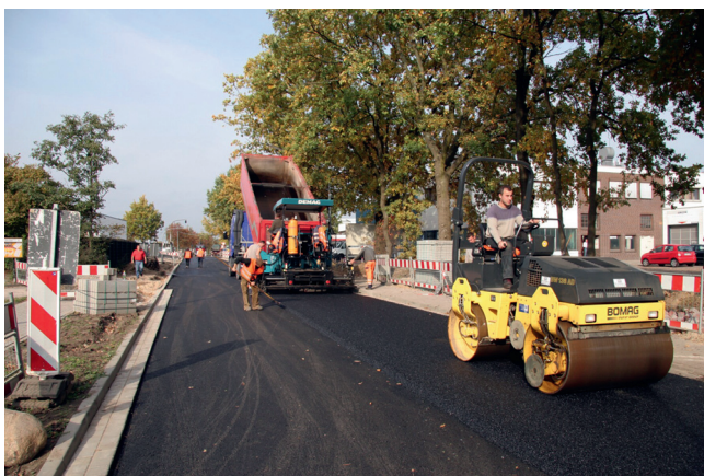
Abbildung 199: Ausbau der Zufahrtsstraße Holzoppel.
