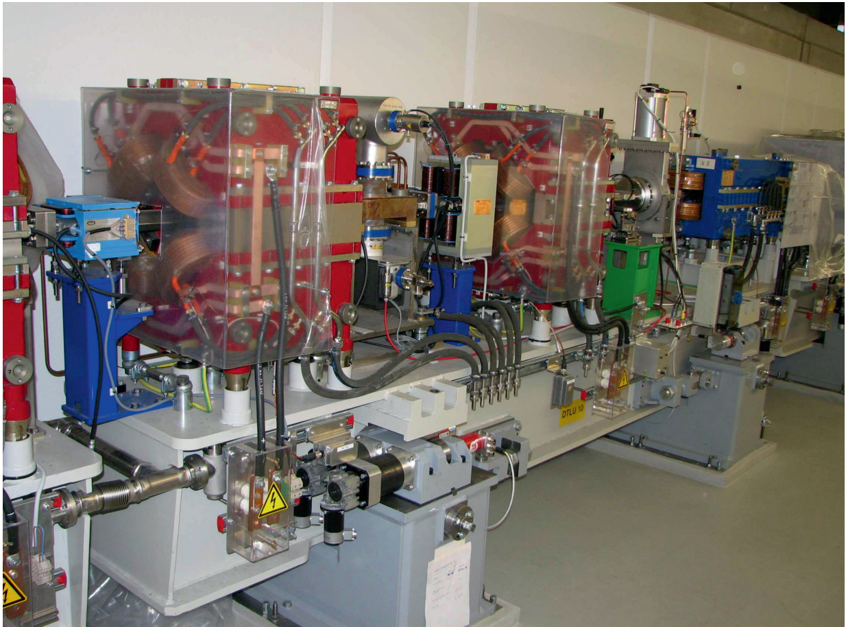
Abbildung 138: Installierter Girder DTLU im neuen Achtel.
