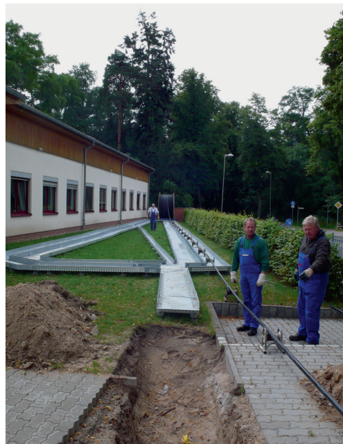
Abbildung 125: Verlegung des Puls-kabels.
